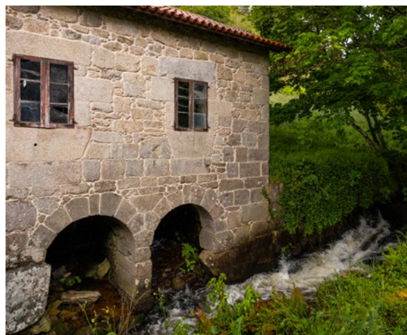
Molino de agua tradicional de dos rodeznos o ruedas hidráulicas en Pesqueiras, actualmente rehabilitado y en funcionamiento. © R. Vilanova
